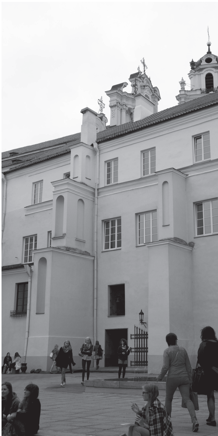
62 pav. Kontraforsai pietinėje Sarbievijaus kiemo pusėje. Manaro Hammado nuotrauka
