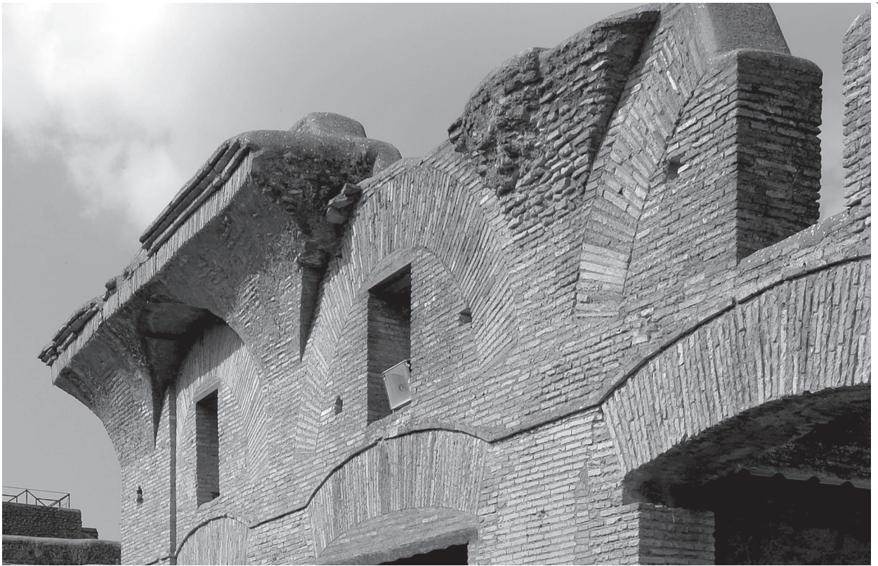
73 pav. Plytinis karnizas Ostijoje, antikiniame Romos uoste. Toks plytų mūriny – tai italų Renesanso mūrinio pirmtakas. Manaro Hammado nuotrauka
