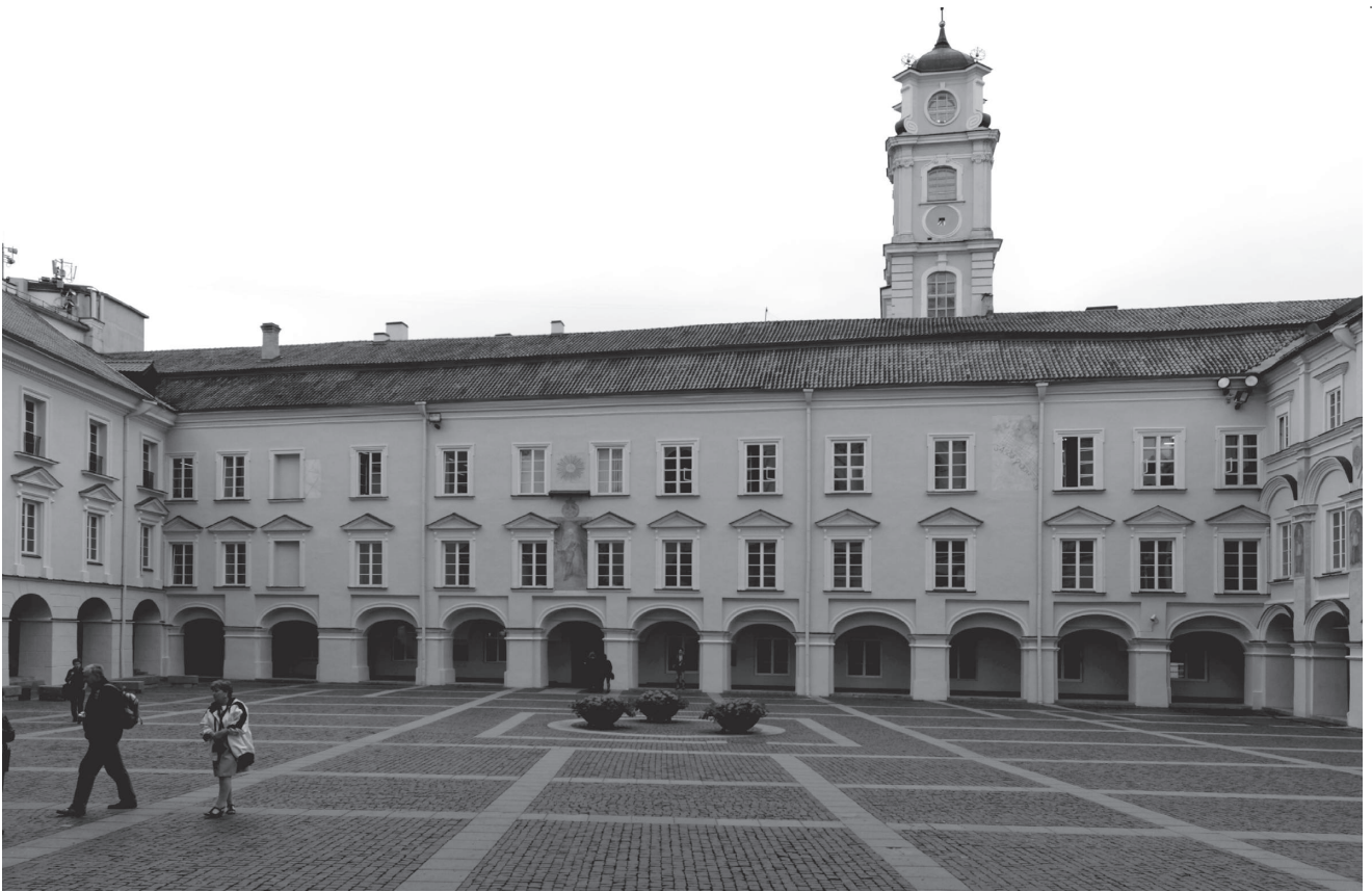
22 pav. Didysis kiemas, žvelgiant į vakarus. Antrojo aukšto freska nėra fasado centre. Rusvos grindinio linijos yra statmenos bažnyčios fasadui, bet su priešinga puse susitinka nestačiu kampu. Manaro Hammado nuotrauka
