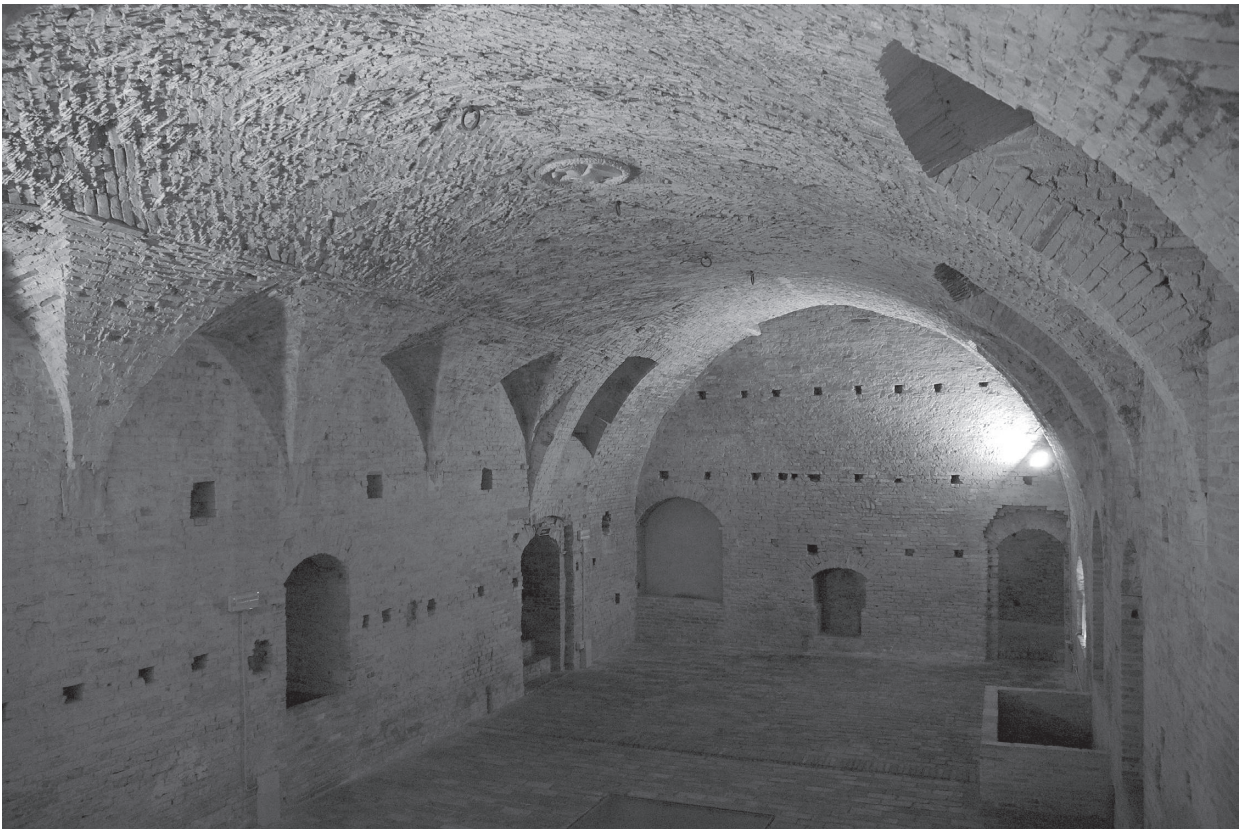
72 pav. Paplokščias skliautas Urbino kunigaikščio rūmų pusrūsyje, kuris niekada nebuvo užtinkuotas, todėl matyti plytų mūrinyš. Manaro Hammado nuotrauka
