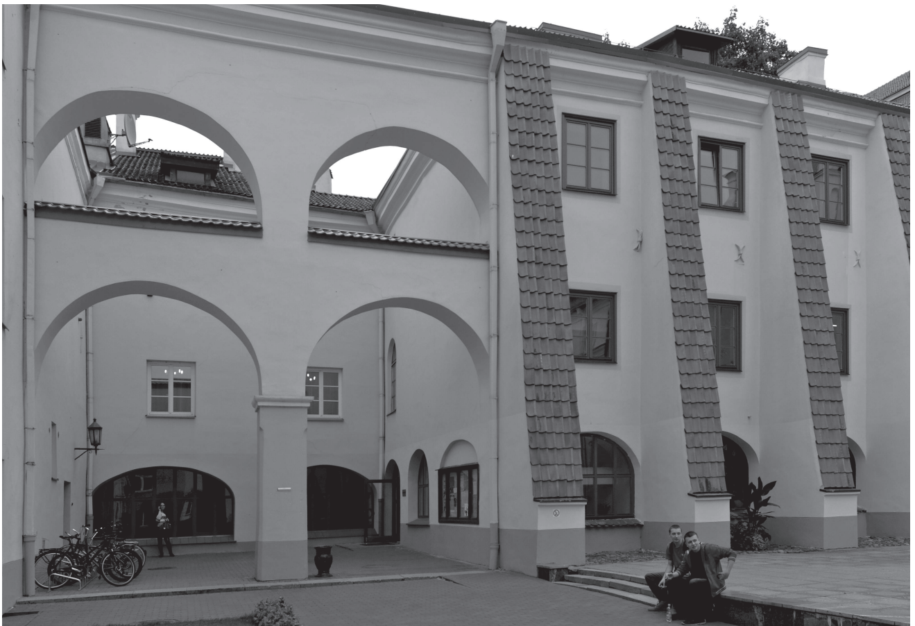
61 pav. Atsparinės arkos ir kontraforsai, stabilizuojantys rytinius Sarbievijaus kiemo pastatus. Manaro Hammado nuotrauka
